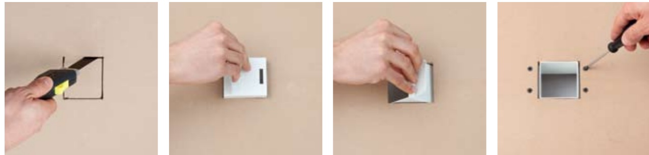
Foro, controcassa, verniciatura, lampada: un modello nato per qualsiasi impiego su controsofitti in cartongesso.
