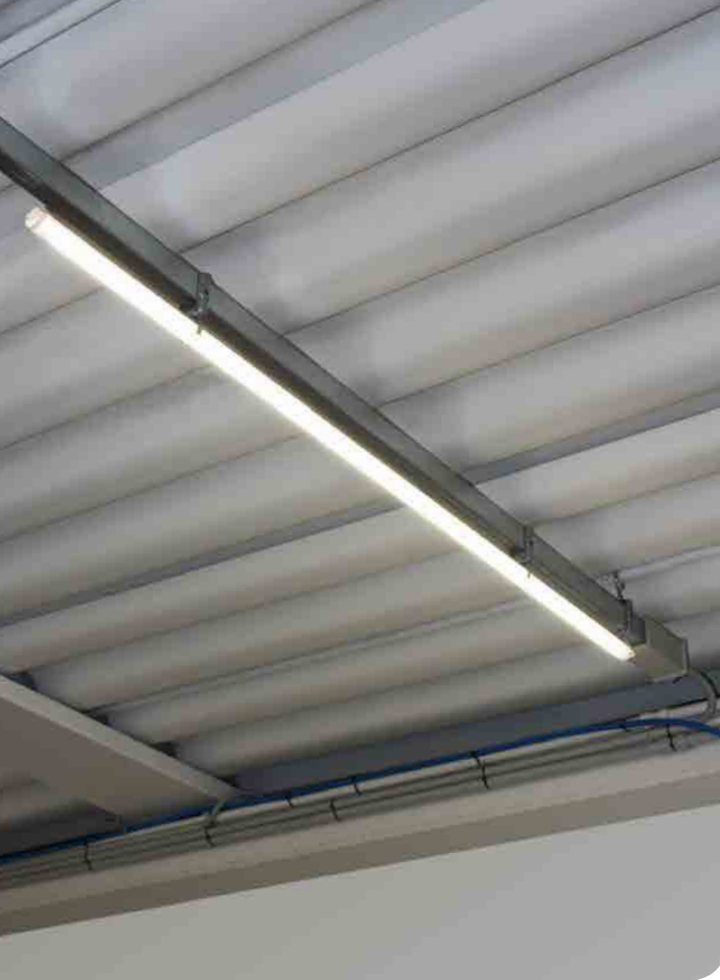
ESEMPIO DI INSTALLAZIONE SU BLINDOSBARRA EXAMPLE OF INSTALLATION ON BUSBAR
